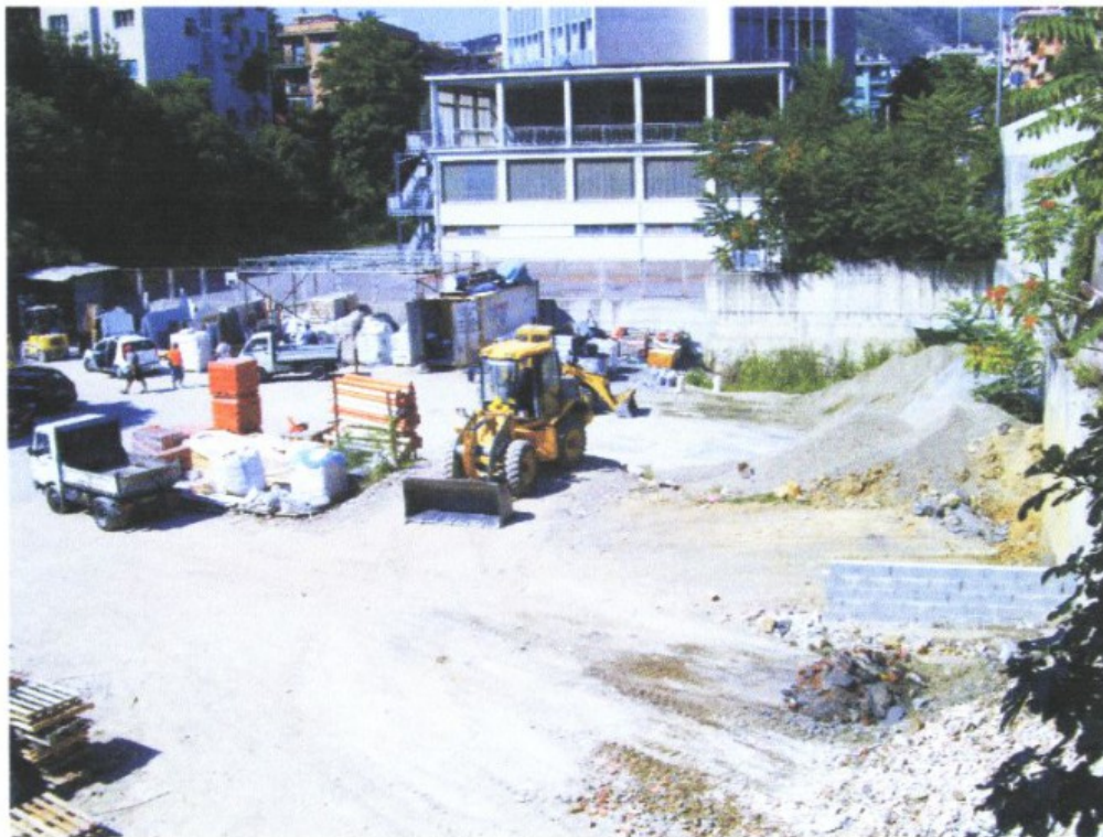
VISTA DELL'AREA DI PROPRIETA' DALLA VIA STURLA (DA SUD VERSO NORD)
