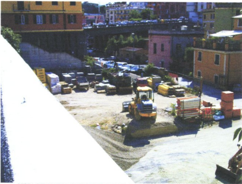
VISTA DELL'AREA DI PROPRIETA' DALLA VIA STURLA (DA NORD VERSO SUD)
